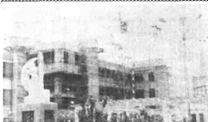
本报讯 (记者张松) 牵动着万千市民心的'95十大利民工程之一的海河小学建设、区三中和区一小扩建,已全面进入内外装修阶段,九月一日将如期开学招生。这是工程承办者市教委、东营区政府负责同志,在接受记者采访时作出的肯定答复。
